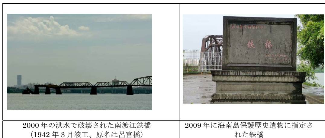
第 18 図 洪水で橋桁を破壊された鉄橋と歴史保護遺物の認定（現在）
