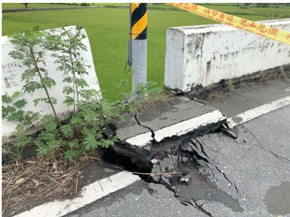
写真1. 台東地震の被害の様子（高寮大橋） 塩川 2022年10月撮影
