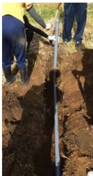
図2 パイプ埋設状況
