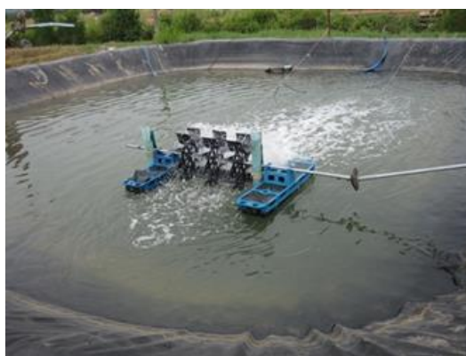
図 12. 水面攪拌式曝気装置を設置した実証試験池
